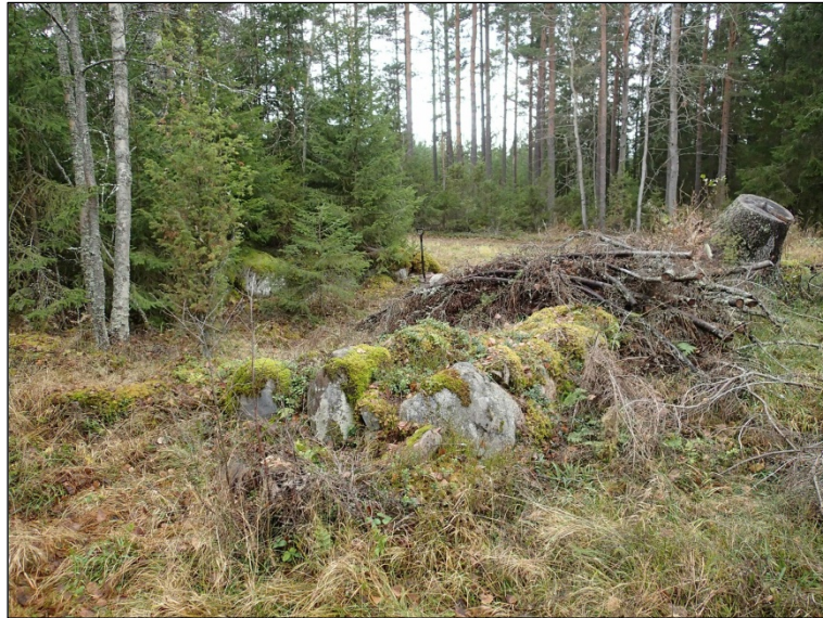
Sikakivi c. Rakennuksen kiviperustusta
